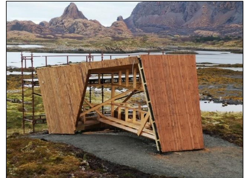
Bygging av padlehuk på Leka
