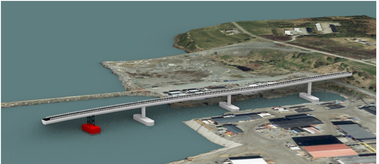
Figur 3-22 Lavbru bygget med tre pongtonger og en lekter, ytterste pongtong er bunnsatt.
