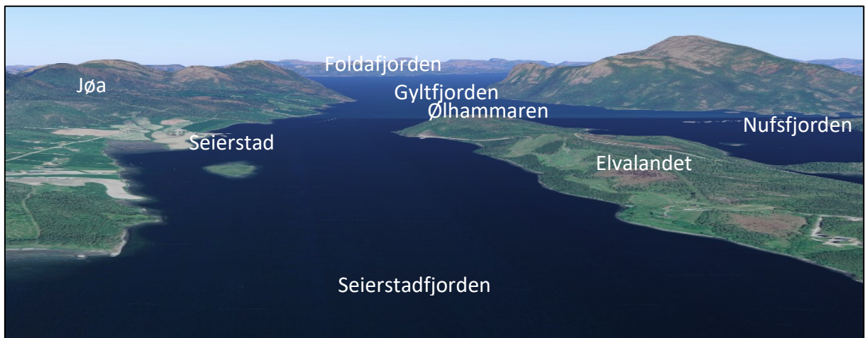
Figur 6-1 Ferjestedet sett fra sør fra Seierstadfjorden nordover mot Gyltfjorden. Seierstad på Jøa til venstre og Ølhammaren på Elvalandet til høyre. Kilde: Google Maps
