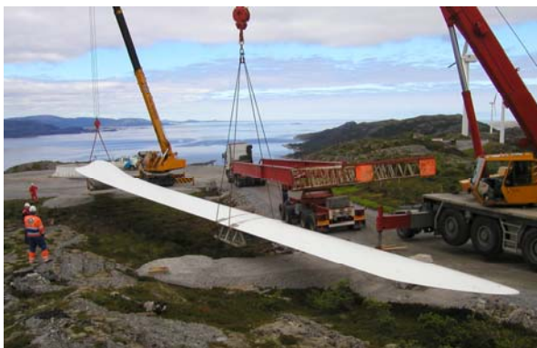
Rotorvinge klar til montering
