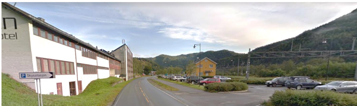
Figur 27: Støren stasjon sett fra sør (Google streetview).
