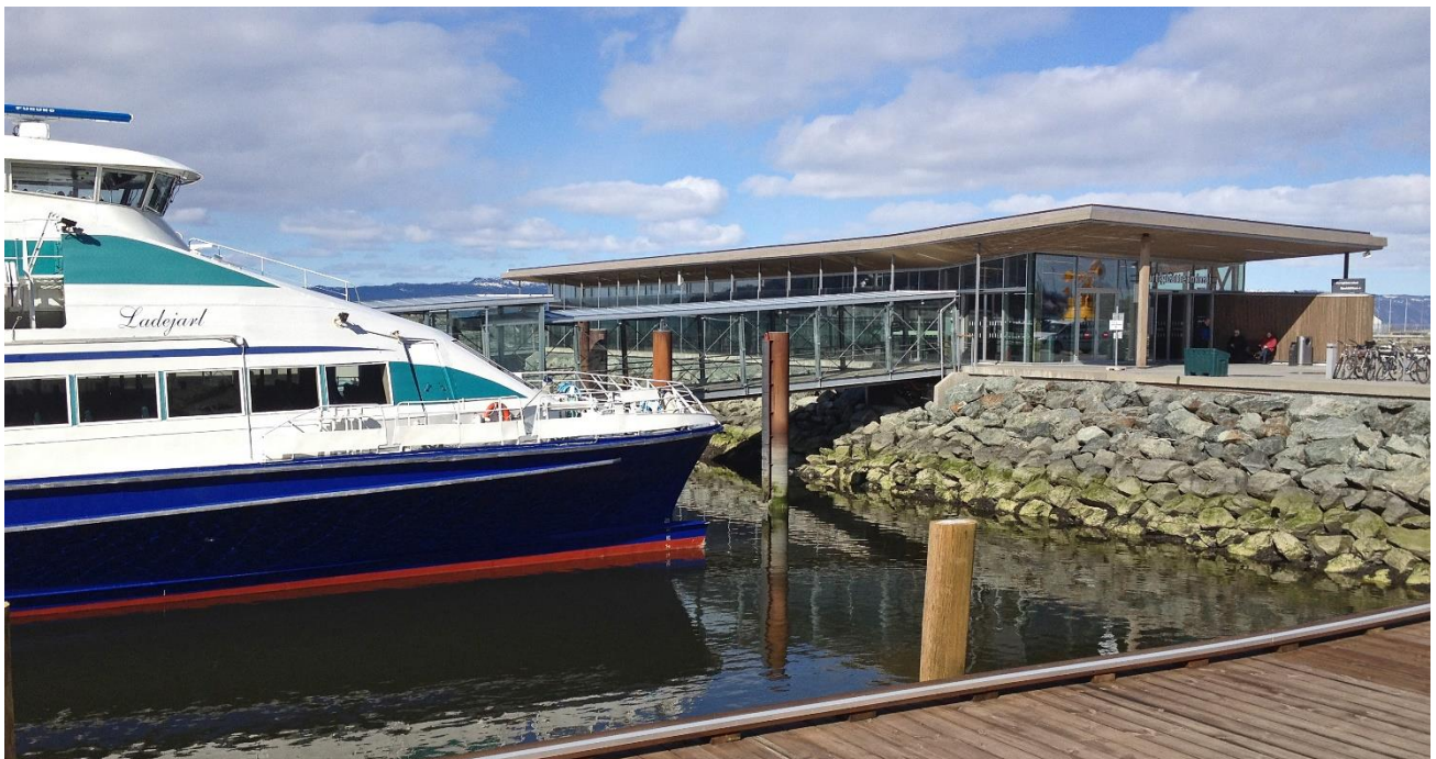
Ferdig bygg – hovedinngang og fasade mot hurtigbåtene
