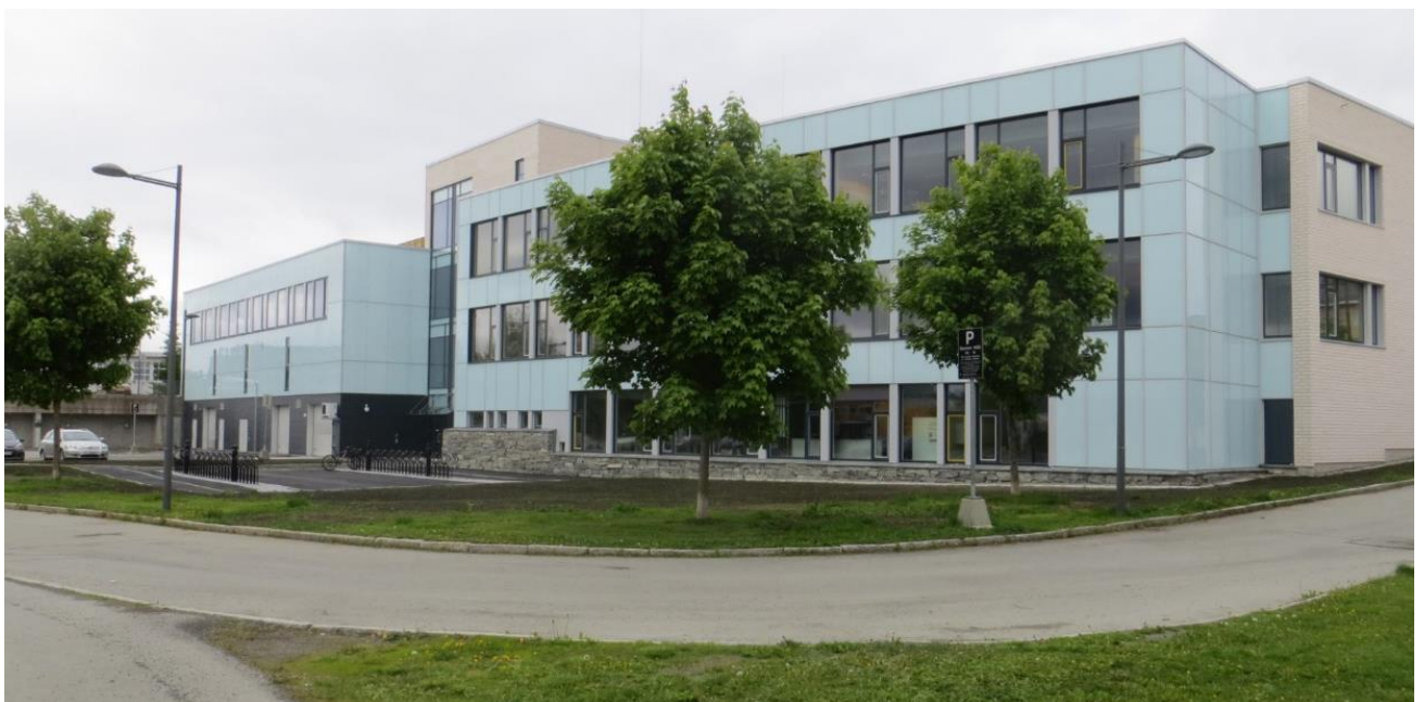
Fasade mot øst, tilbygg 2016 for Trondheim fagskole
