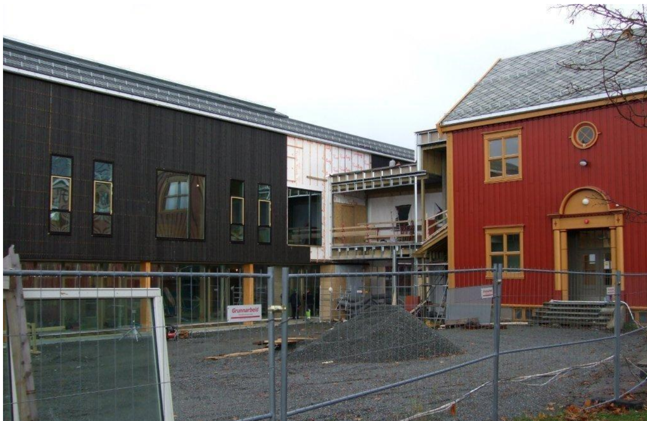
Nytt bygg B og gammelt bygg A under sammenbygging.
