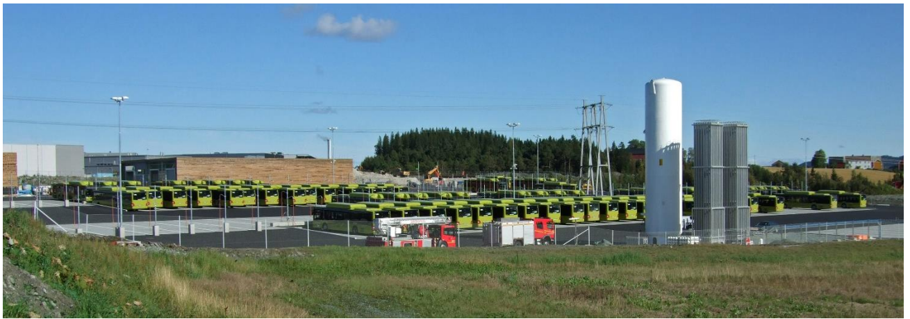
Gassanlegget i forgrunnen, ved rutinebesøk fra brannvesenet. Alt var i orden.
