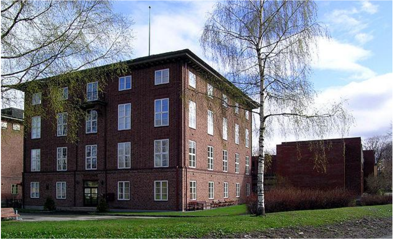
Bygg A ved skolen før utbygginga i 2013.
