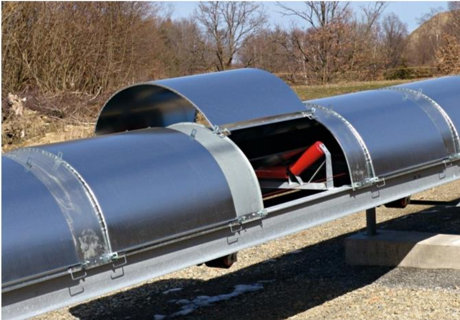
Figur 5: Lukket transportbånd løftet opp på fundamenter (Kilde: AT Mineral Processing)
