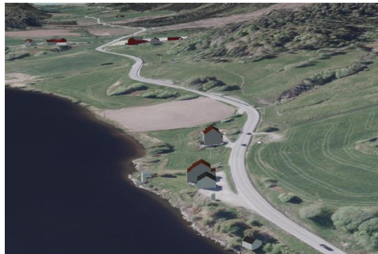
Figur 4.15 vegparti med dårlig kurvatur, Nakling
